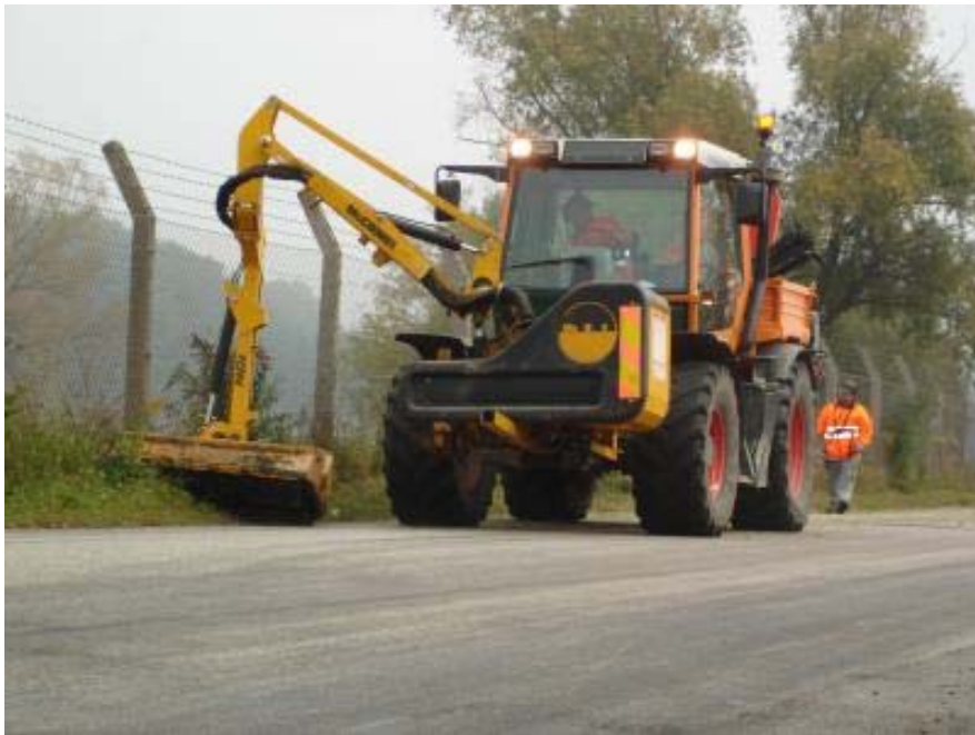
Mitarbeiter der Straßenmeisterei bei der Arbeit
